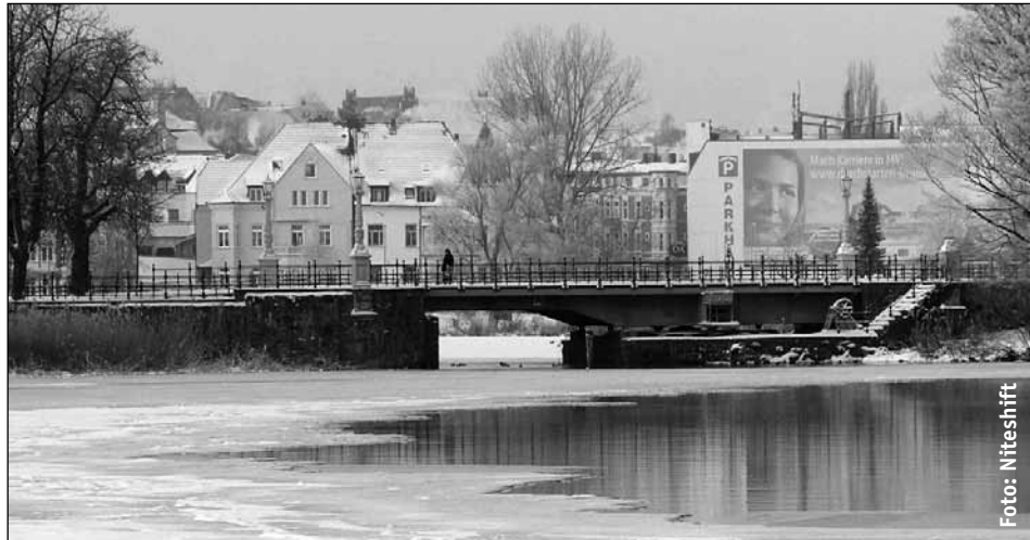
Die Schlossgartenbrücke in Schwerin ist der Teufelsbrücke recht ähnlich. Dort gelang eine denkmalgerechte und kostengünstige Sanierung.
