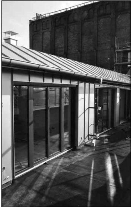
Bald sind die Lofts und Wohnungen bezugsfertig
