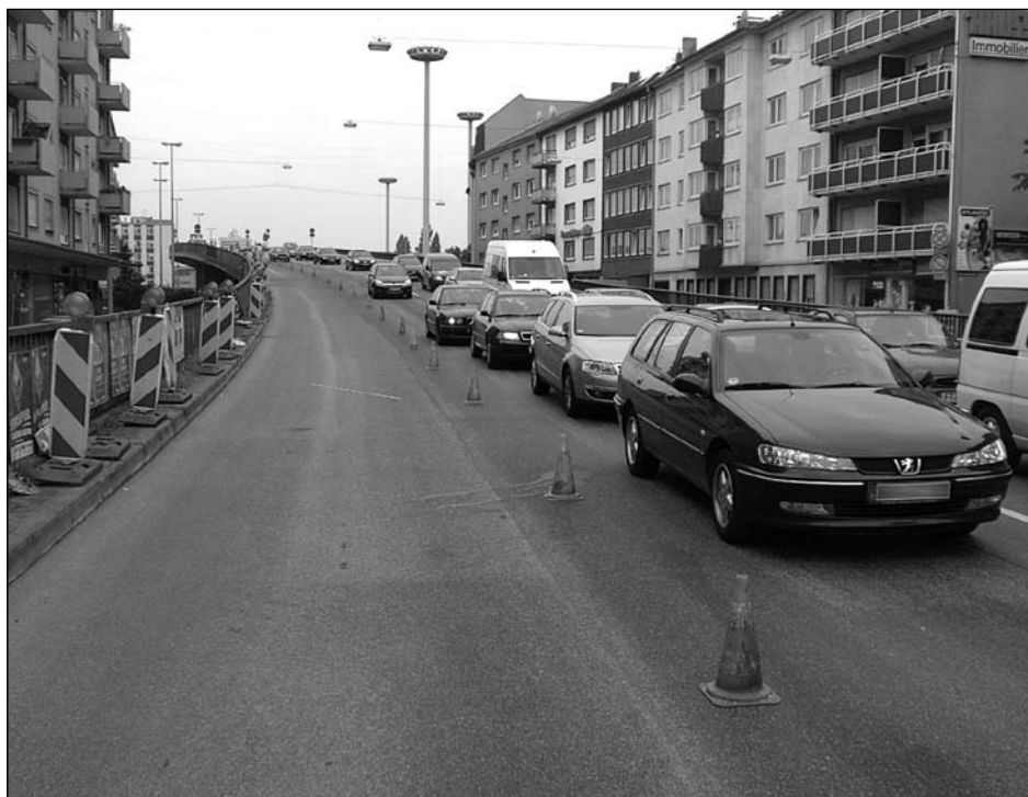
Neue Fahrbahnbeläge bringen mehr Ruhe für die Anwohner.
