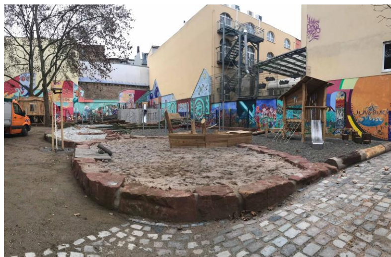
Spielplatz Beilstraße nach Renovierung
