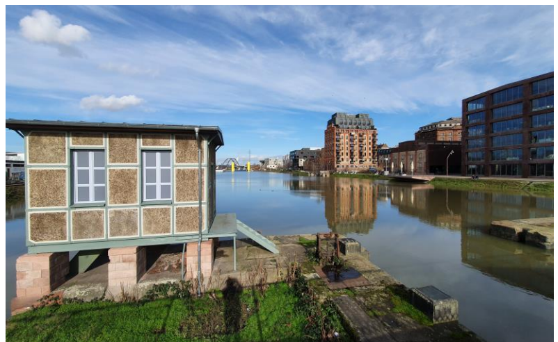
Partie am Verbindungskanal mit Maschinenhaus auf der Teufelsbrücke, Musikpark, Silogebäude der Kauffmannmühle, Popakademie, Port 25 und C-Hub.
